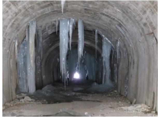
〔写真-2⑤B〕 坑内の巨大氷柱群。米沢側を望む。手前左側最初の氷柱群、右側2番目の氷柱群、2号内巻(段差箇所)が見え、その奥に巨大氷柱群。
