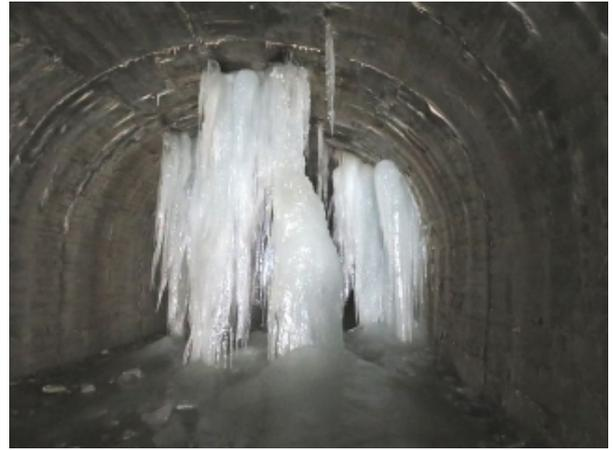
〔写真-3①B〕 坑内最大の巨大氷柱群、福島側か望む。2号内巻区間内(20~30m奥)、福島側坑口から約100m付近。
