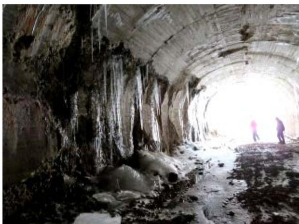
【写真-5①A】 米沢側坑口、例年の巨大氷柱出現箇所、つらがが僅かに見える。
